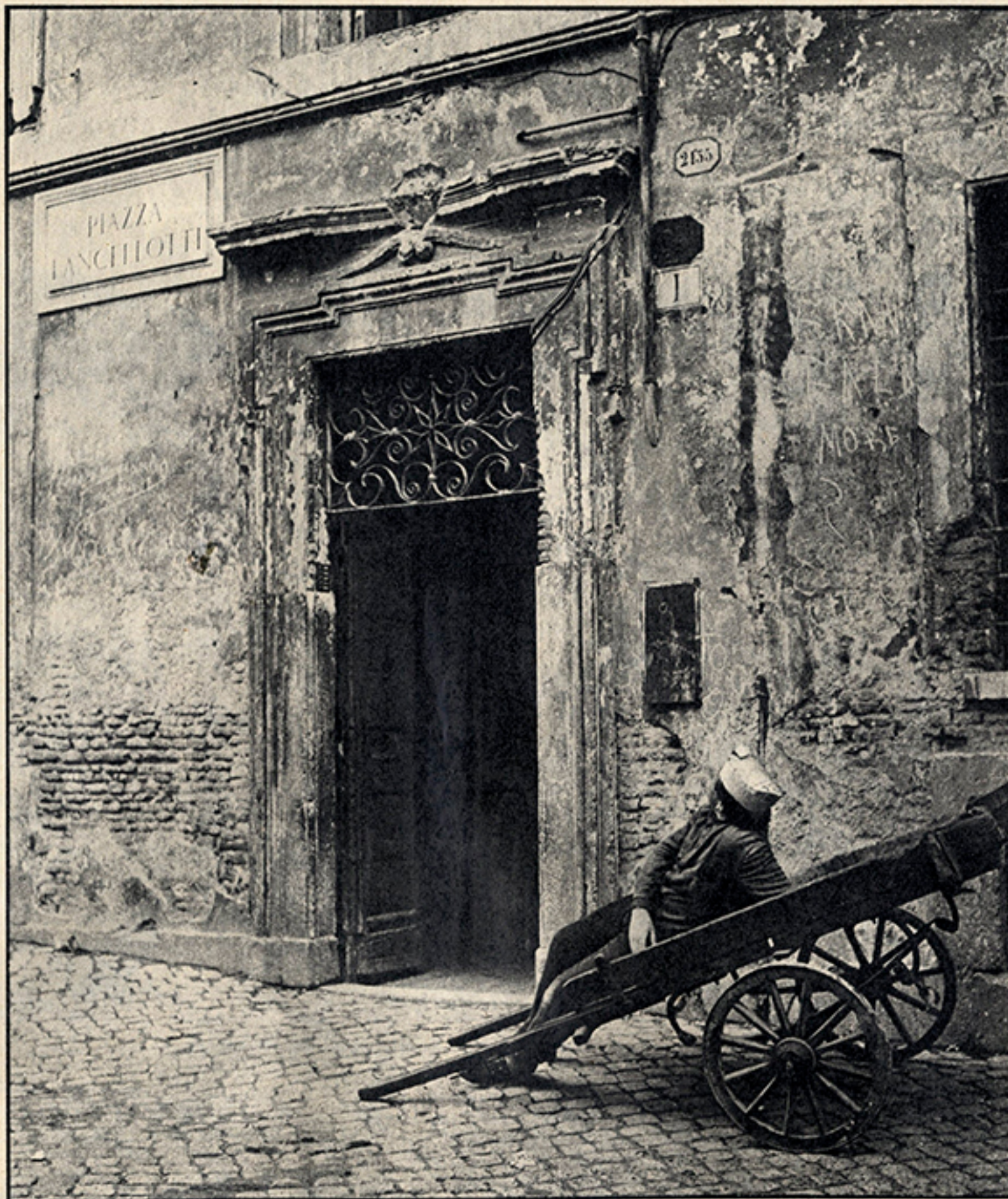
Roma, Piazza Lancellotti. Il portale di un palazzo seicentesco minacciato di demolizione.
