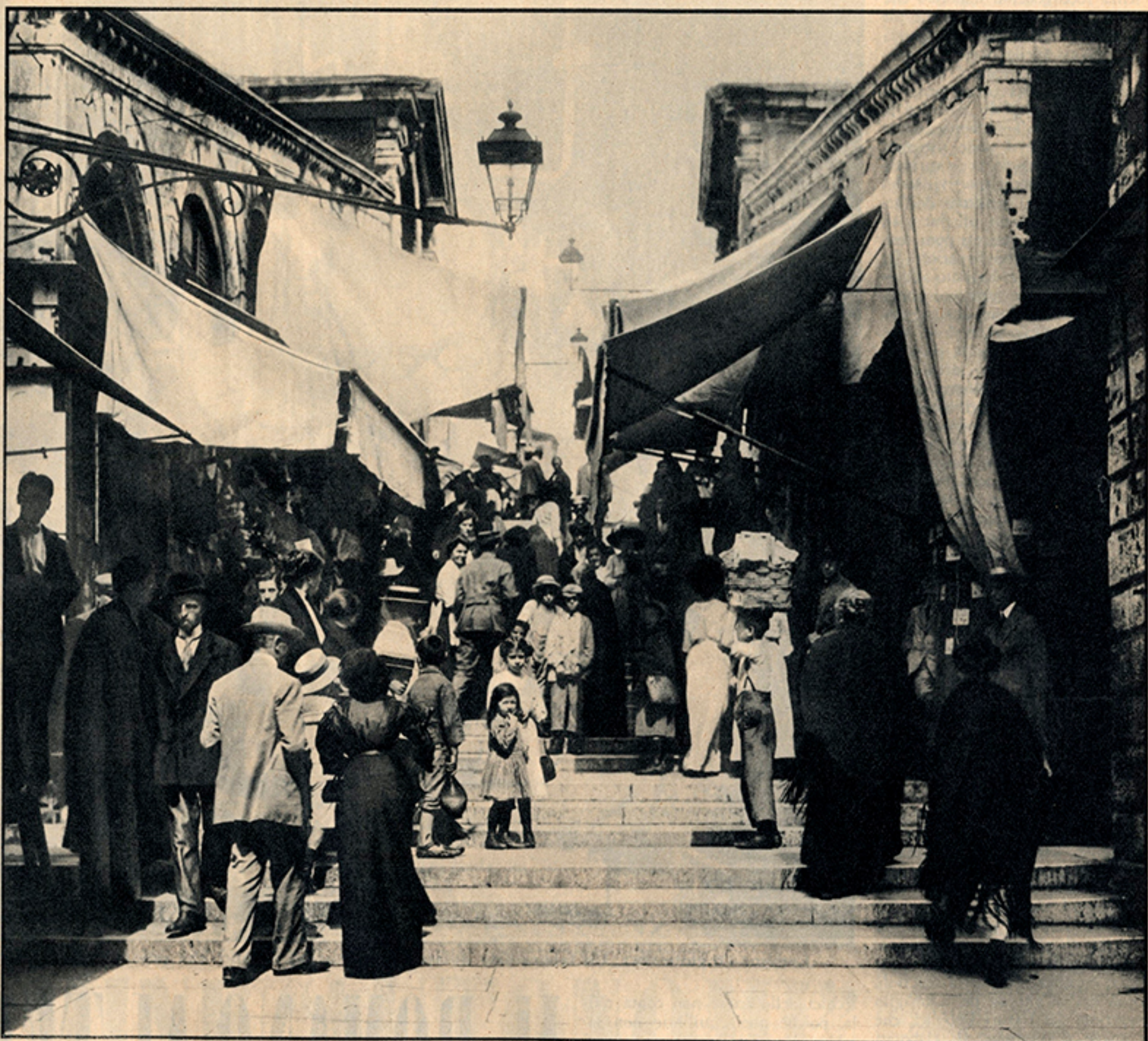
Venezia 1900. La scalinata del Ponte di Rialto.
