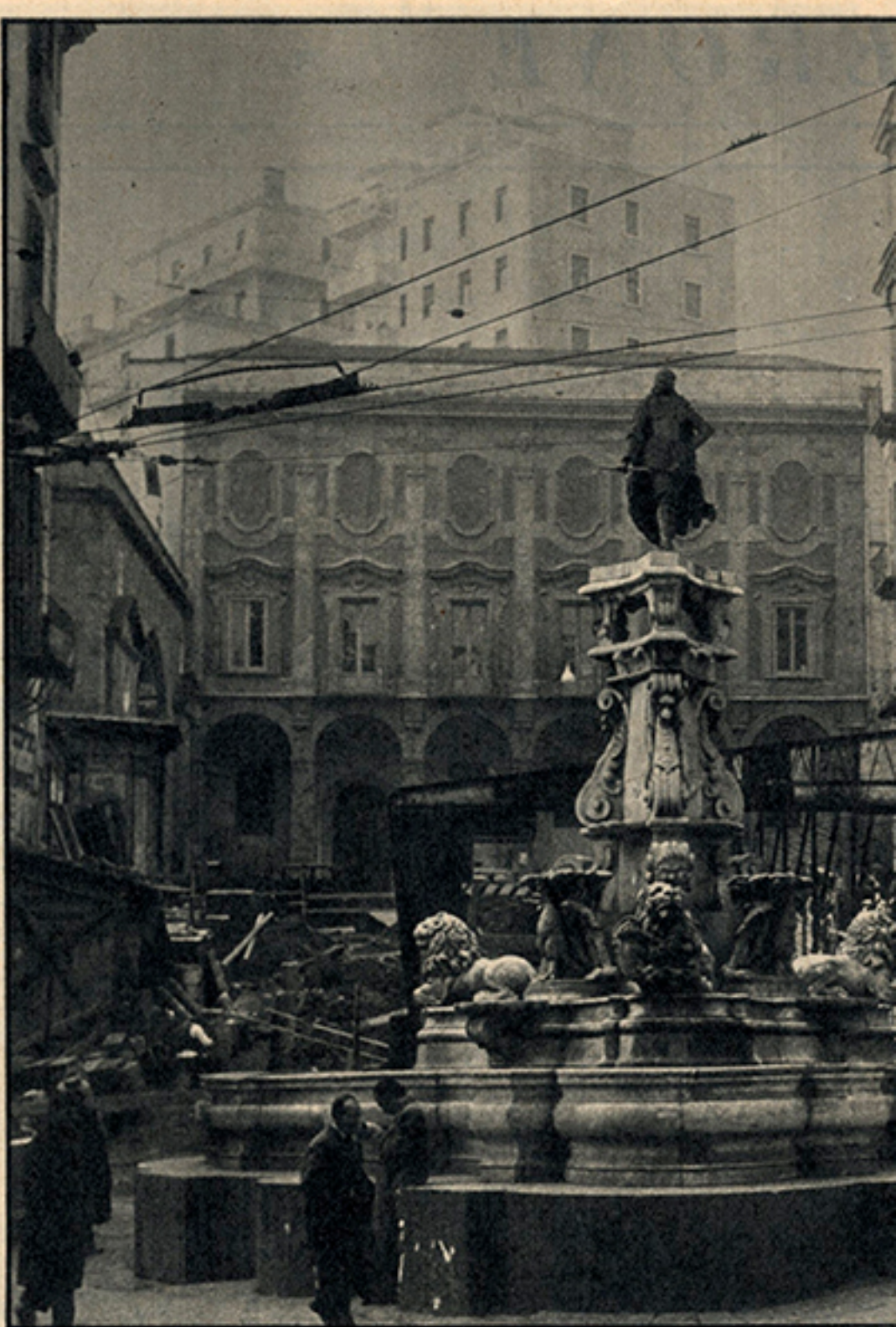
Napoli, piazza di Monteoliveto. Si iniziano i lavori per l'eliminazione
