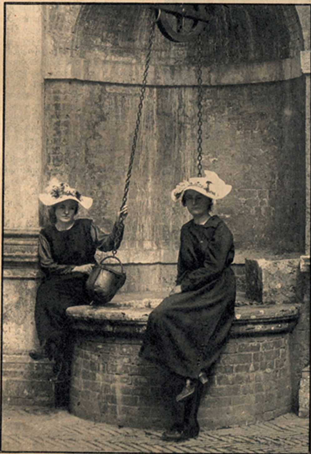
Siena (Dintorni). Il pozzo del Castello di Belcaro.
