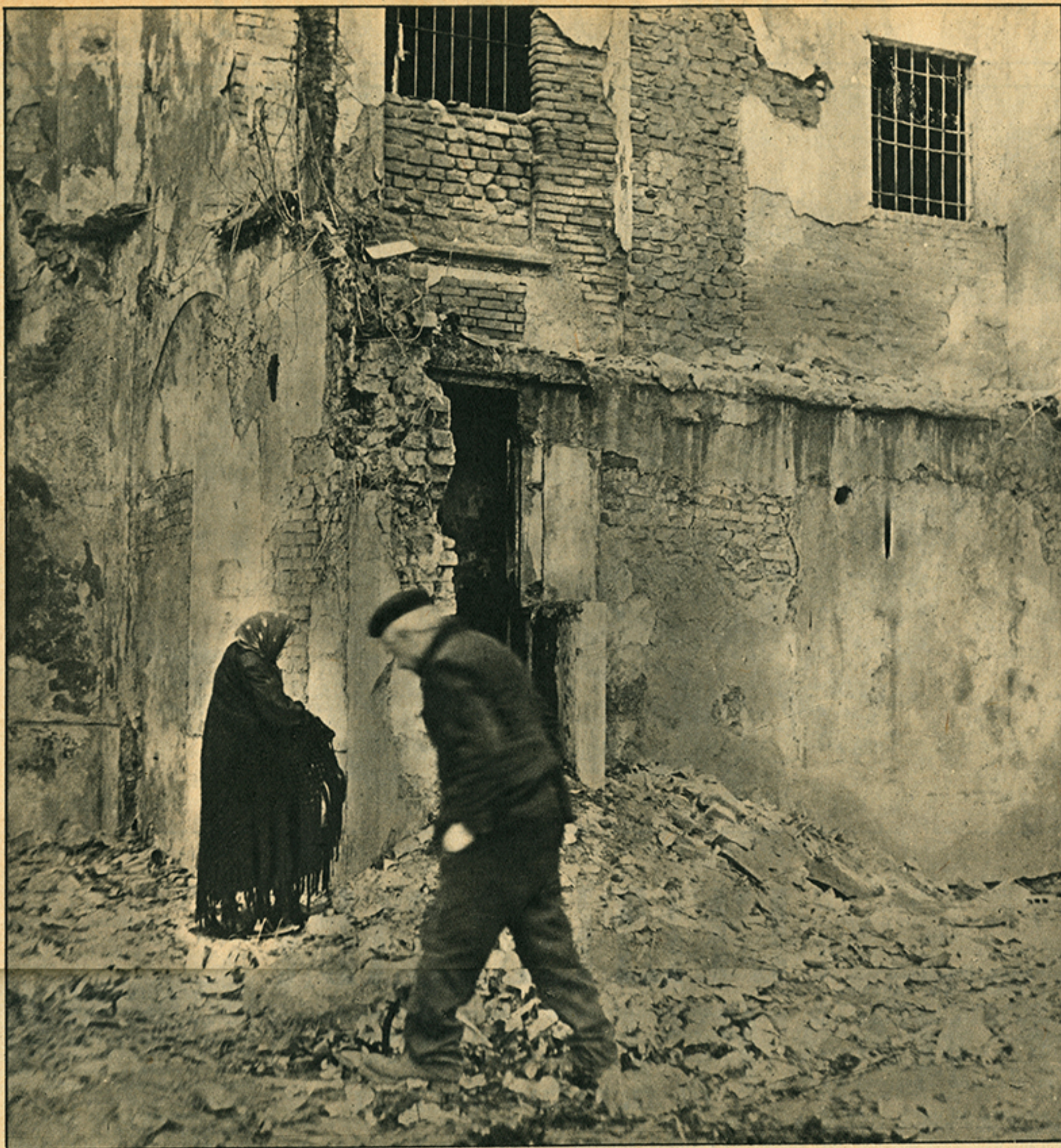
Milano. Demolizioni al centro della città.
